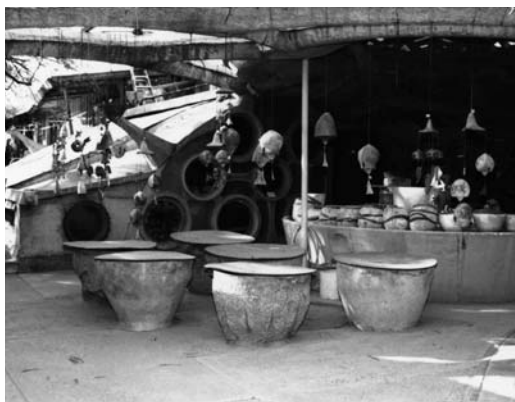
Paolo Soleri, COSANTI Keramikwerkstatt, 1958. Die Keramikwerkstatt ist eine große, in Erde gegossene Betonkuppel mit einer runden Deckenöffnung. Das Studio ist gegen Süden ausgerichtet, um die trocknenden Strahlen der niedrigen Wintersonne auszunützen.
