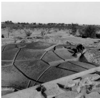
Paolo Soleri, COSANTI Keramikwerkstatt, 1958. Ausgehöhlte Erdform für den ursprünglichen Zeichenraum in Cosanti in Paradise Valley, Arizona
