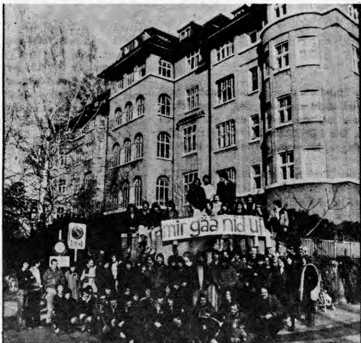
Die in den Häusern verbliebenen Mieter organisieren sich und wollen sich wehren.
