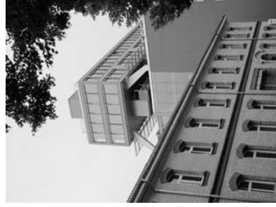
Fig. 5+6: «Wohnen und wirken, wo die Stadt lebt»: Auf dem ehemaligen Areal der Seifenfabrik Steinfels entsteht Wohn-, Büro- und Gewerberaum. Der Wolkenbügel (unten) überspannt die gesamte Siedlung.
