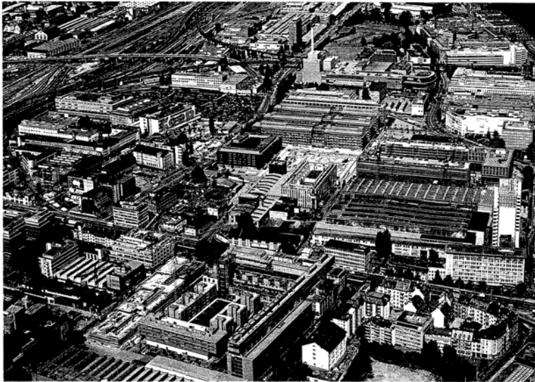
Blick auf Zürich West, 2003. Zwischen Limmat und Gleisfeld die industrietypischen Grossbauten, deren Massstäblichkeit bei Neubauten übernommen wird. (Foto Desair)
