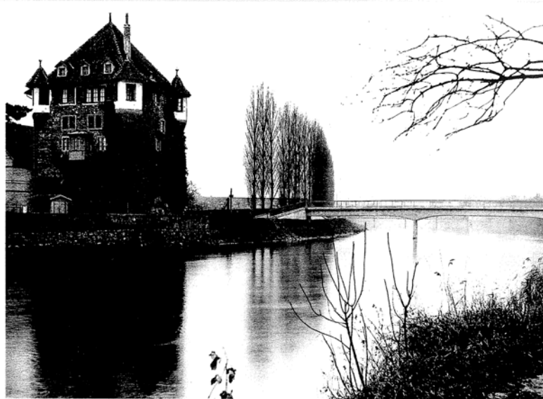
Der mittelalterliche Hardturm (Hardturmstrasse 136) markiert die Westgrenze des Industriequartiers. Er war im 13. Jahrhundert Teil der Letzi, einer vorgelagerten Befestigungsanlage der Stadt. (Foto W. Gallas 1931, BAZ)
