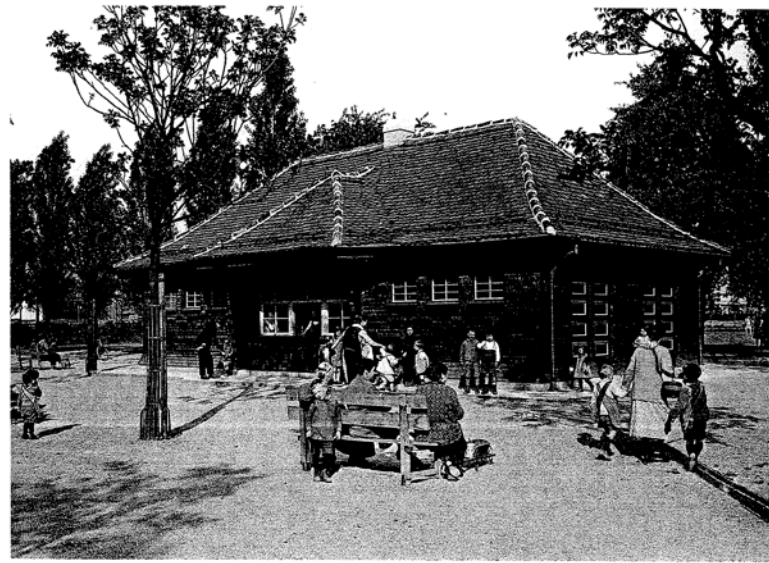
1926 liess die Stadt Zürich zwei noch unbebaut gebliebene Hofquadrate an der Josefstrasse zum Park herrichten: Die Josefwiese ist bis heute der wichtigste öffentliche Freiraum im Quartier. Das geschindelte Holzhäuschen von Stadtbaumeister Hermann Herter evokiert gesunde Ländlichkeit. Hier wurde Milch an Kinder verkauft (Josefstrasse bei 199). (Foto Wolf-Bender um 1927, BAZ)
